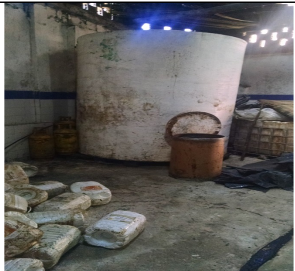
Foto No. 2. Tanque metálico para almacenamiento de aceite.
